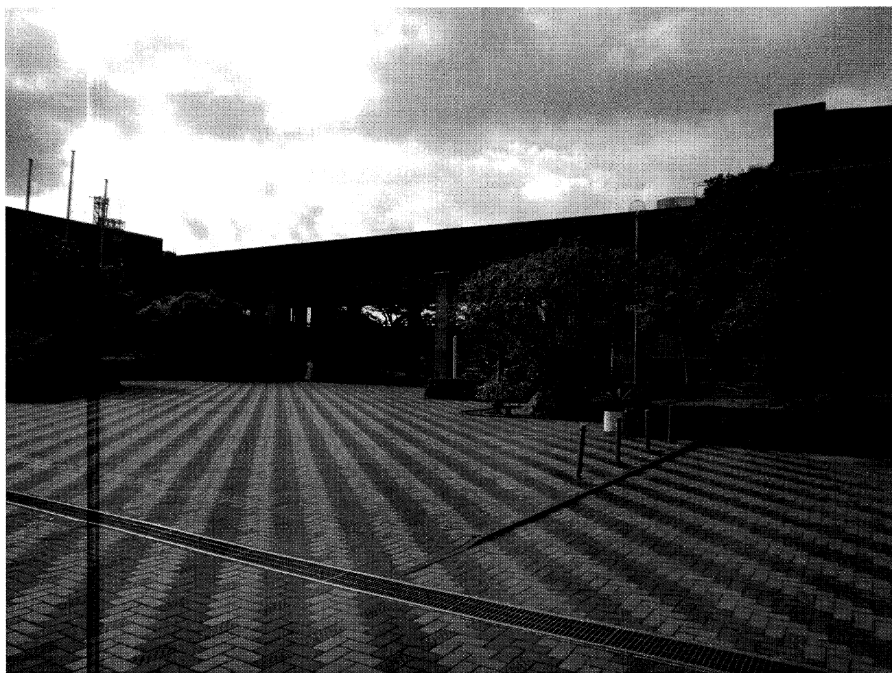
＜石垣市民会館外観＞
