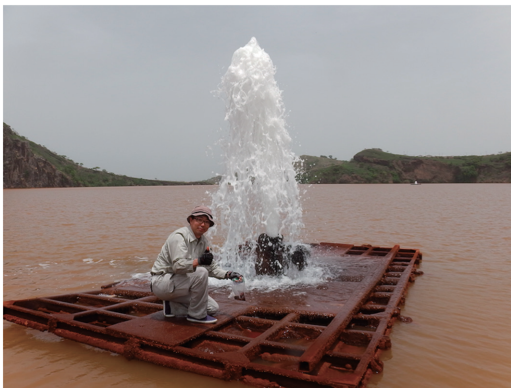
図2：ニオス湖の自噴式ガス抜きパイプの筏にのる著者。2016年3月撮影。調査プロジェクトが始まった2011年には、噴水の高さは、20mを越えていたが、深層水の順調な脱ガスにより、噴水の勢いは弱まった。
