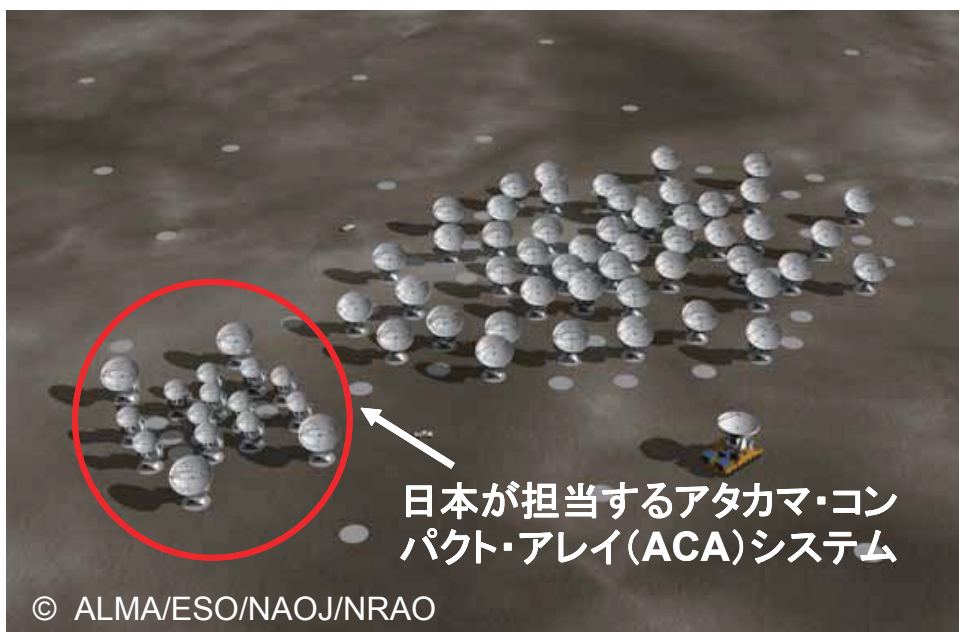
図1：ALMAの完成想像図。移動台車で配置を変えて、観測を行う。最も広げたときには大きさが18.5 kmにもなる。図は、最もコンパクトな場合。右側の一団が12mアレイ。赤枠内がACA。ACAの四隅の大きめのアンテナがTPアレイ、中の小さなアンテナが7mアレイ。
