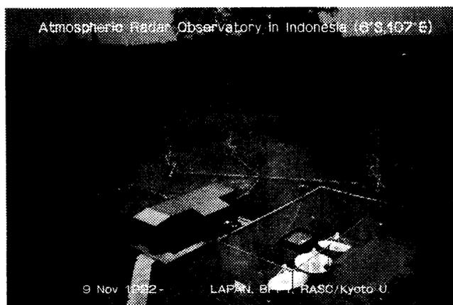
図4 インドネシア国ジャカルタ市郊外スルボン地区にある国立科学技術研究センター (PUSPIPTEK) の一角に、「新プログラム」の一環として建設された観測所 (津田敏隆氏による)。手前のパラボラアンテナ3基が「境界層レーダー」、後方の八木アンテナ4基が「流星レーダー」である。
